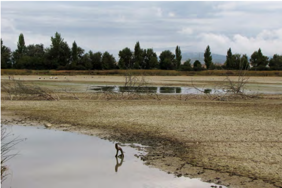
Vista de la balsa de Arcaute con nivel de agua muy bajo.
